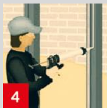
4 Нанесение клея
