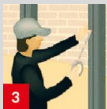
3 Нанесение компенсационной ленты
